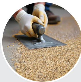
Pokládka povrchu TopStone
